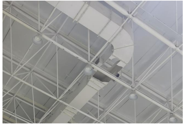
顶棚通风管东北角拐角处出现损坏
